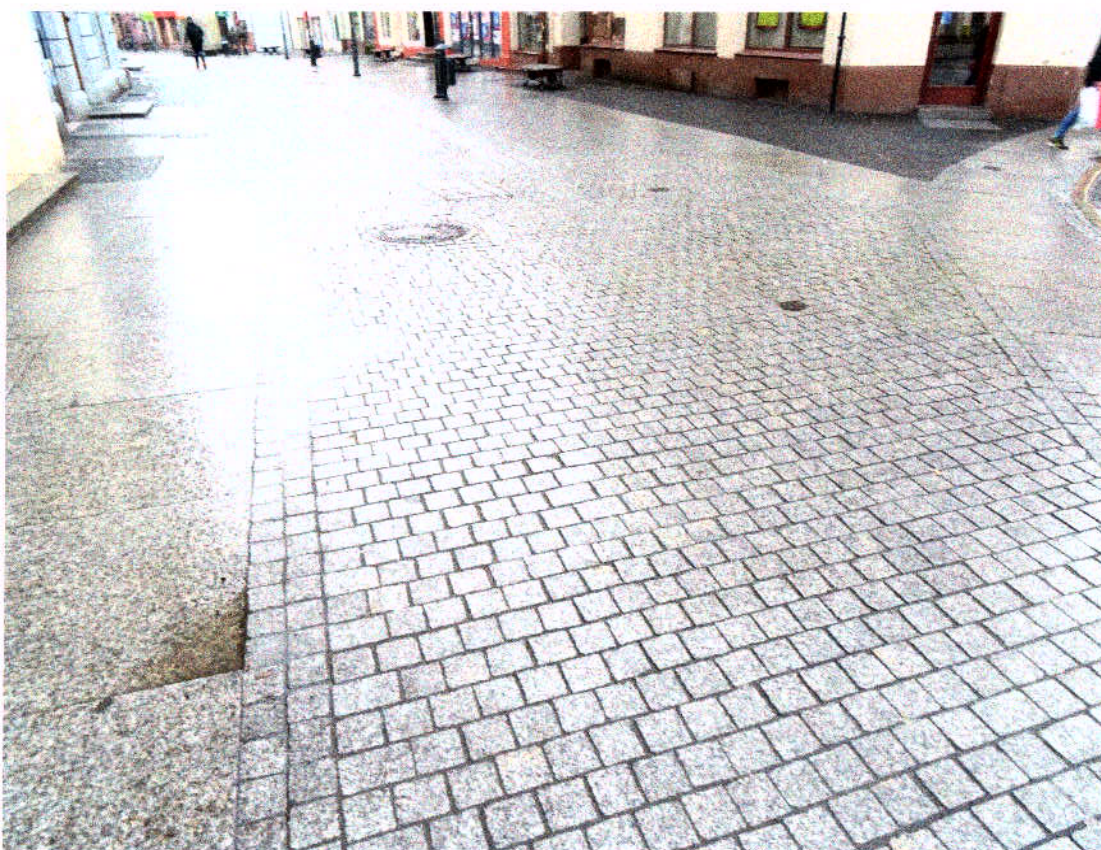
Nawierzchnia sąsiedniej ulicy Chrobrego i z kostki granitowej.
